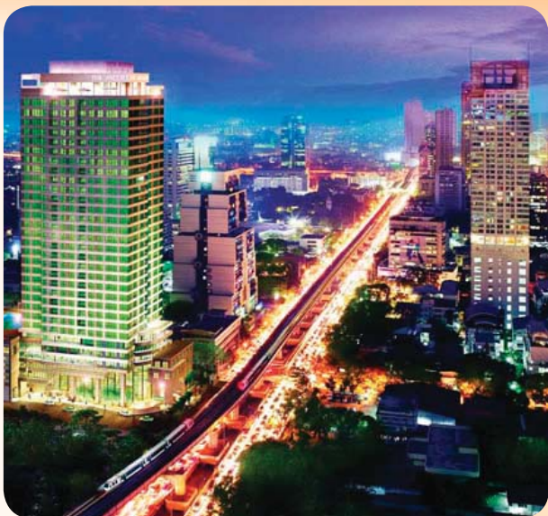
อาคารขนาดใหญ่หลายแห่ง ใช้พลังงานไฟฟ้ามหาศาล
