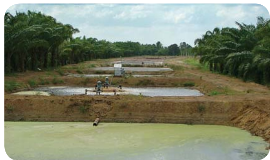
ระบบบำบัดน้ำเสียแบบเติมอากาศ จำนวน 3 บ่อ อยู่ถัดจากบ่อน้ำบำบัดน้ำเสียแบบพึ่งอากาศของโรงงานฯ
