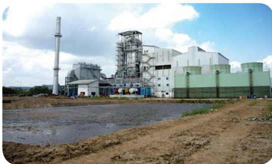
บ่อน้ำบำบัดน้ำเสียแบบพึ่งอากาศ จำนวน 3 บ่อ ตั้งอยู่บริเวณด้านหลังของโรงงานผลิต
