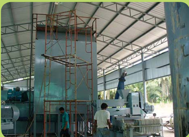
การจัดสร้างเครื่องสกัดน้ำมันปาล์มระบบแห้งหีบรวม (Dry Process)
