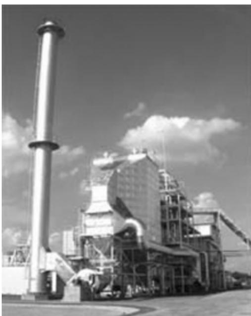
เทคโนโลยีของระบบนี้แตกต่างจาก 3 ระบบแรกโดยสิ้นเชิงเพราะไม่ใช่ไอน้ำแก๊สซิฟิเคชัน (Gasifier) เป็นการเผาไหม้ชนิดหนึ่ง โดยควบคุมอากาศไหลเข้าในปริมาณจำกัด ทำให้เกิดการเผาไหม้ที่ไม่สมบูรณ์ จะได้ก๊าซคาร์บอนมอนนอกไซด์ และไฮโดรเจนเป็นหลัก ซึ่งสามารถนำไปเป็นเชื้อเพลิงได้
