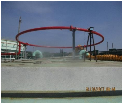
รูปที่ ๑๐ งานติดตั้งท่อดับเพลิง
