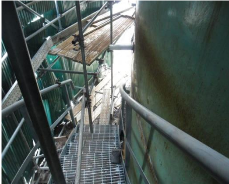
รูปที่ ๙ งานติดตั้งบันได และราวกันตก
