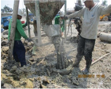
รูปที่ ๒ เจาะเสาเข็มและหล่อฐานราก
