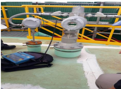
รูปที่ ๑๑ งานติดตั้งท่อดับเพลิง
