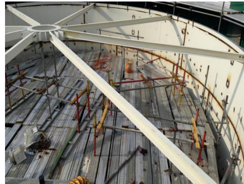
รูปที่ ๖ ติดตั้งโครงหลังคาถังเก็บน้ำมัน
