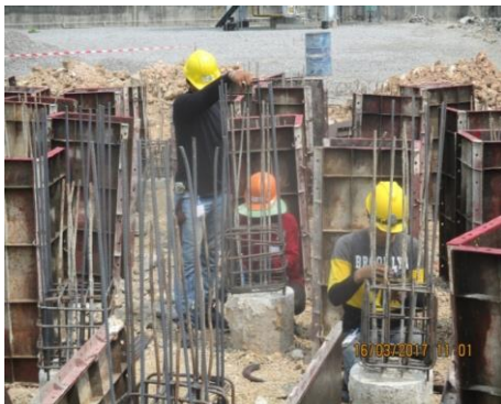
รูปที่ ๓ ติดตั้งเหล็กเสริมคอนกรีตฐานราก
