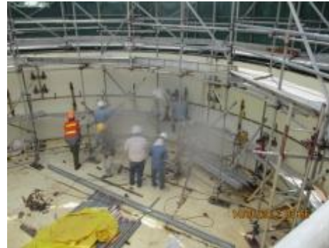
รูปที่ ๕ ปูแผ่นเหล็กพื้นถัง แผ่นเหล็กวงแหวนรองใต้แผ่นเหล็กผนังถังและเชื่อมประกอบแผ่นเหล็กผนังถัง
