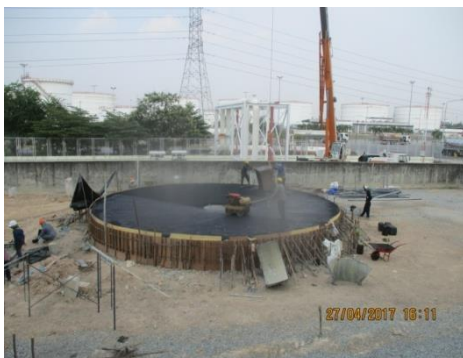
รูปที่ ๔ พื้นฐานรากของถังเก็บน้ำมัน
