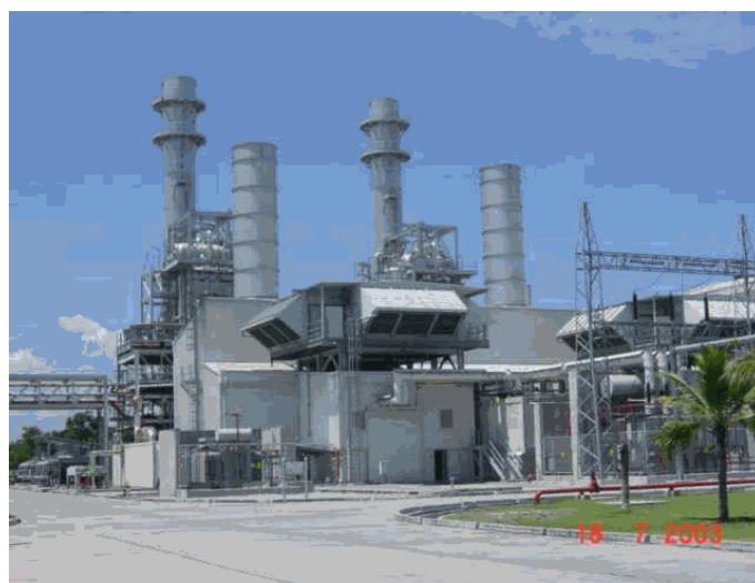
โรงไฟฟ้า SPP
