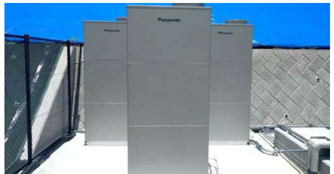
รูปที่ 5 แสดงตัวอย่างต้นแบบระบบกักเก็บพลังงานระบบเซลล์เชื้อเพลิง (Fuel Cell)
